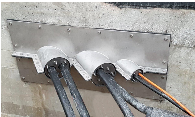
解决方案: 根据电缆的穿出角度, 测量带有不同的管接头出口的凸出 法兰。 图片: 电缆引入介质通道
