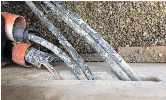
细节图: 电缆引入介质通道
