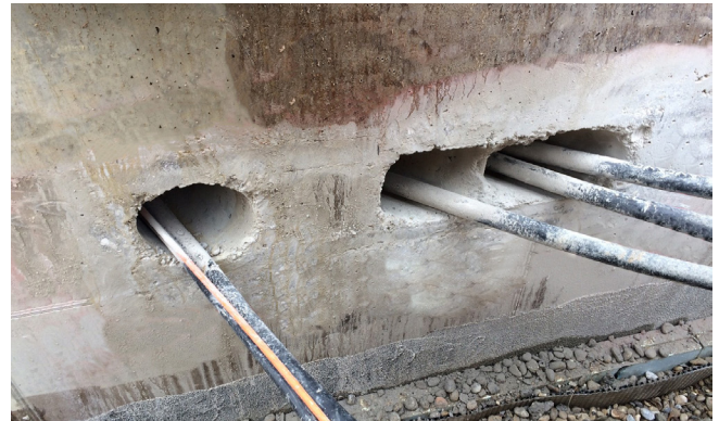
特殊之处: 电缆以不同角度进入和穿出介质通道。电缆的位置无法更 改。 图片: 电缆从介质通道中穿出
