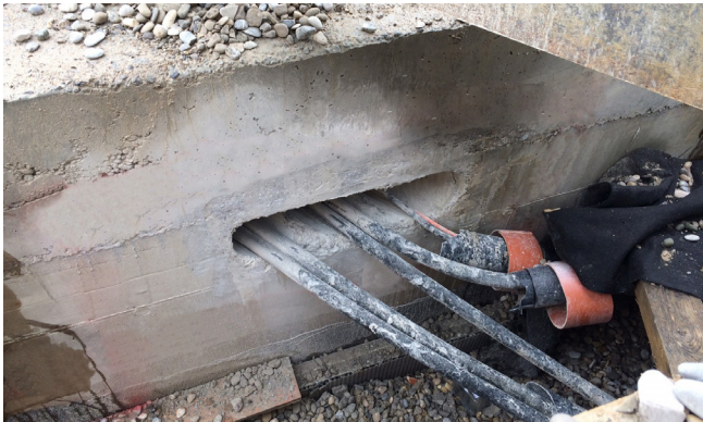
在建造可通行的介质通道的过程中, 现有的总供应管道无法迁移。在 施工过程中, 电缆周围预留了一部分空间。 图片: 电缆引入介质通道
