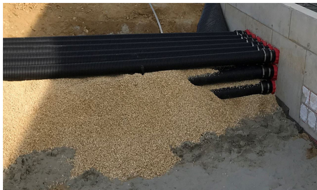
Dokončno nameščene zaščitne cevi na tesnilih HSI 150.
