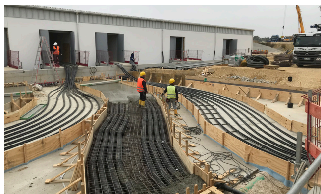
Betoniranje cevne povezave med novogradnjo in obstoječimi zgradbami.
