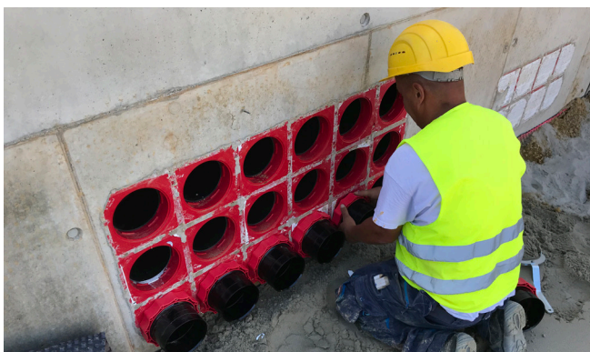
Montaža poklopca sustava HSI 150 – M168 WR za naknadno priključivanje valovitih zaštitnih cijevi za kabele.
