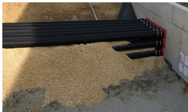
Gotove montirane zaštitne cijevi na paketima brtvila HSI 150.
