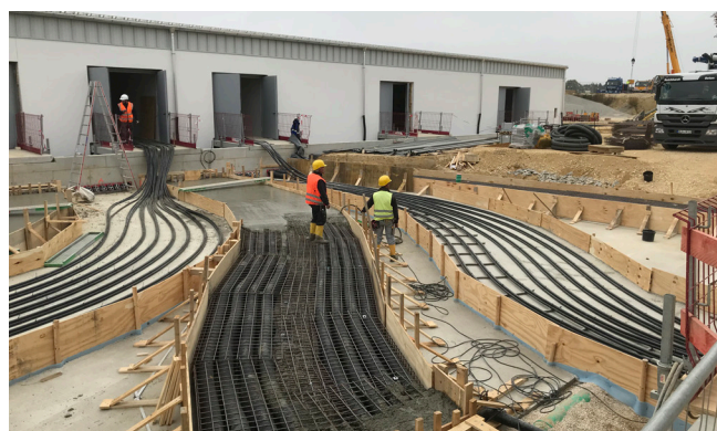
Bétonnage du raccordement de la gaine de protection entre le nouveau bâtiment et les bâtiments existants.
