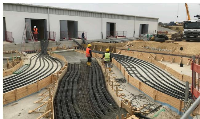
Hormigonado de la conexión de conductos entre la nueva edificación y los edificios existentes.
