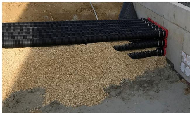
Conductos ya instalados en insertos en pared HSI 150.
