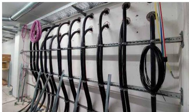
Das Ergebnis ist eine saubere, wasser- und gasdichte Wanddurchführung der Firma Hauff GmbH.&CoKG. Das Zusammenspiel zwischen Businesspartner der Firma Hauff GmbH.&CoKG und der ausführenden Firma hat in diesem Fall sehr gut funktioniert, da bei dem gewählten Produkt HRDi genaue Angaben in Bezug auf Kernbohrloch/Futterrohr und Medium-Leitungen Außendurchmesser gemacht werden mussten.
