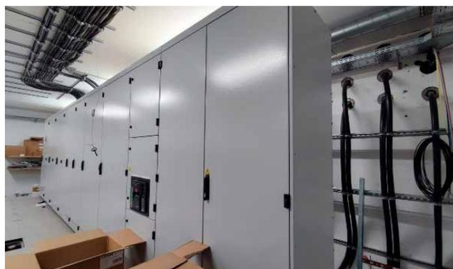
Im Haupt-Bürogebäude befindet sich im Keller ein zentraler Energie-Versorgungsraum. Von dort aus werden die einzelnen Werkstattbereiche mit Energie versorgt.
