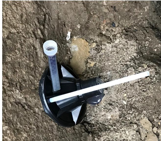
Uvod se zabrtvluje kroz stručno probušeni provrt od 30 mm na gradištu uz pomoć 2K ekspanzijske smole prema vanjskom zidu.
