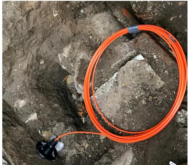
Cijev Speedpipe debljine 7 – 10 mm stručno se uvodi u GFH 30.
