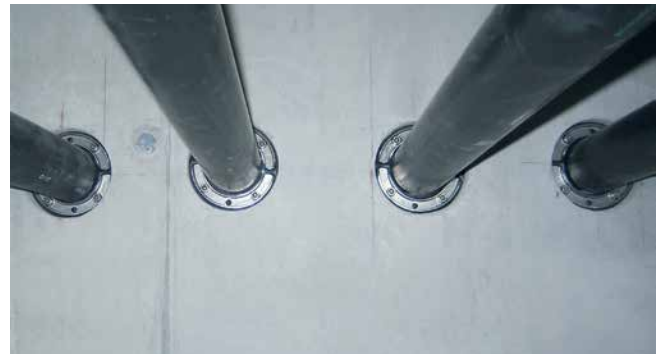
HSD125 1x75 b20 A2/EPDM55 empty conduit connection
