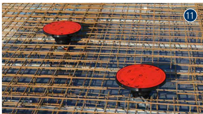
AT110 przed zabetonowaniem
