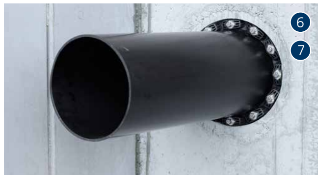
Uszczelnienie rury tworzywowej przy użyciu FZR i GKD400
