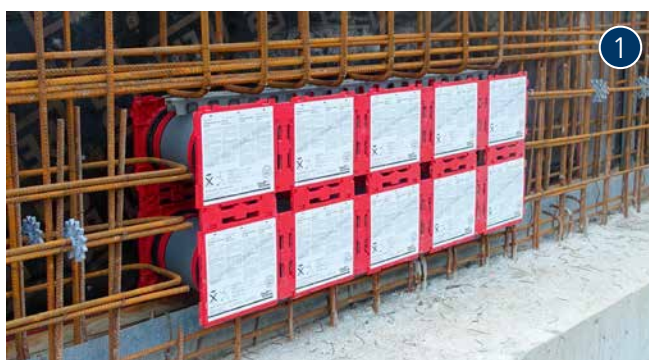
Montage van de dubbele dichtpakking HSI150 K2 voor het instorten
