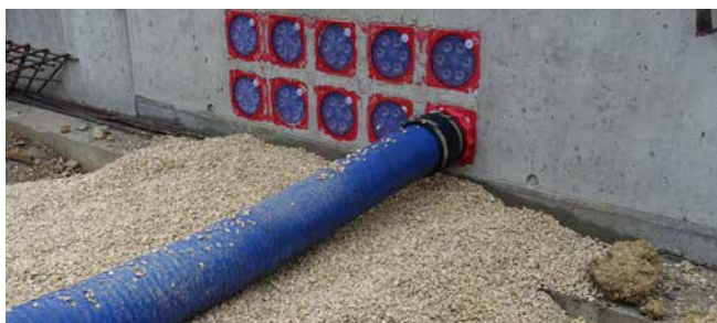
Anschluss des Kabeleinführungssystems KES MA150 D
