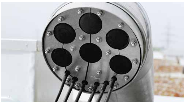
Montierter Dichteinsatz SKD in Schwanenhals SHD 200
