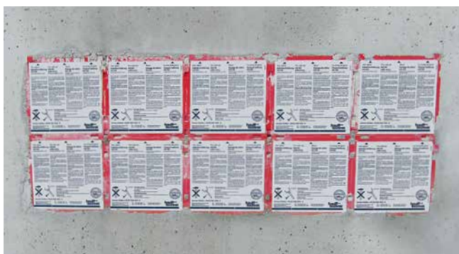
Doppeldichtpackung HSI150 als Paket
