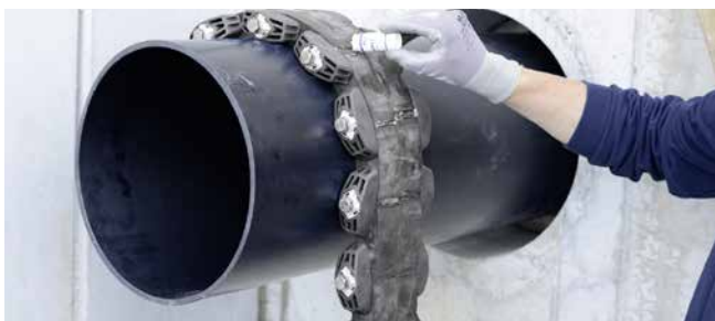
GKD400 – Montagevorbereitung mit Gleitmittel GM
