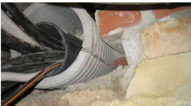
FZR100 / 240 Abdichtung Rohrtrasse
