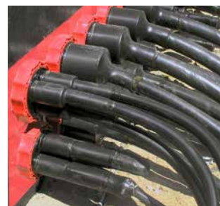
Stationseinführung: Niederspannungskabel abgedichtet mit HSI90 D1x75 WS und HSI90 D3x32 WS
