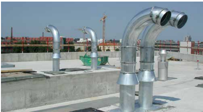
Montierte SHD200 vor Verlegung der Dachabdichtung
