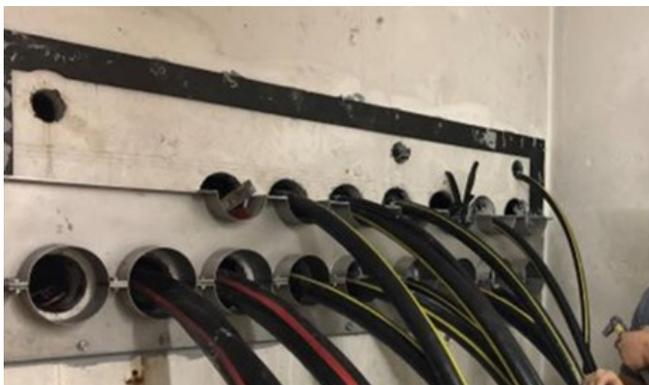
È stata scelta una soluzione con flangia in modo da potere chiudere a tenuta le irregolarità dei fori di carotaggio e dei tubi di protezione, che sono stati parzialmente annegati nel calcestruzzo a filo con la parete interna.
