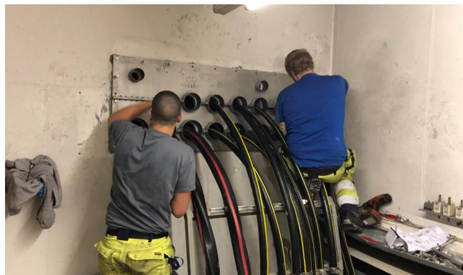
Grazie alla realizzazione divisa della flangia, quest'ultima è stata montata intorno ai cavi esistenti. Per l'installazione non è stato necessario né interrompere la corrente né infilare nuovamente i cavi.
