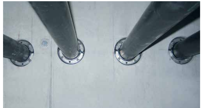
HSD125 1x75 b20 A2/EPDM55 empty conduit connection
